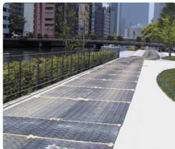
建築現場車両通路
