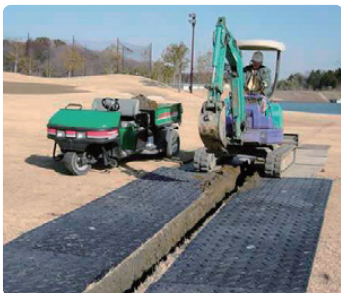
ゴルフ場整備
