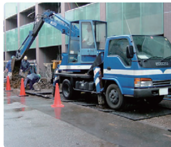
マンション外溝工事
