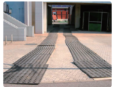
インターロッキング養生
