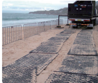
護岸工事(砂地養生)
